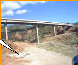
Camino de acceso
